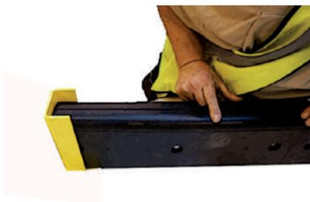
**04** Insérez le module Stopshock dans les supports en U
