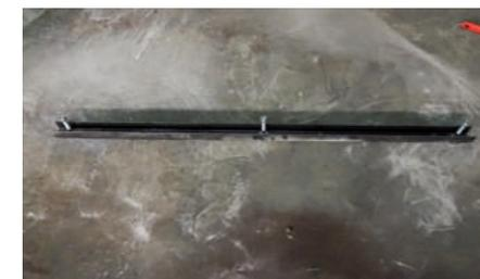
**03** Placer le profil U au niveau des trous et y mettre les goujons M12. Avec un maillet, taper sur les goujons avec l'écrou en bout de course. Serrer les écrous avec une boulonneuse.
