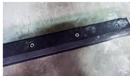
**05** Recouvrir le profil oméga avec le caoutchouc. Placer les rondelles M10. Introduire les vis M10 dans les trous. Serrer avec un boulonneuse.
