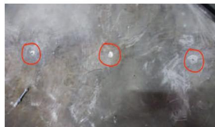
**02** Retirer le profil U et percer le sol avec un foret de Ø 12mm au niveau des marques. Balayer la poussière.
